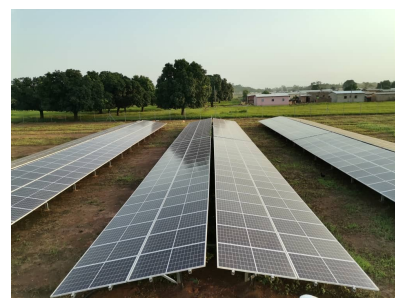
Mali: Ländliche Elektrifizierung
